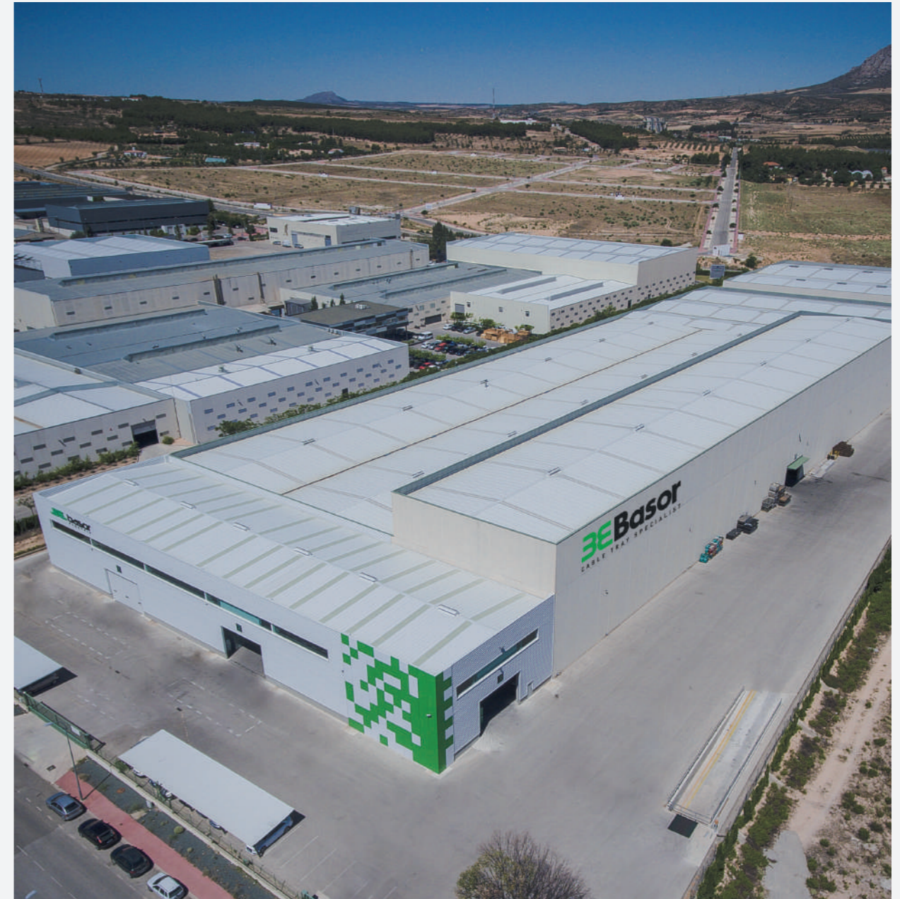
Megafactoría de Almansa (Albacete-España) / Almansa Megafactory plant (Albacete-Spain)
